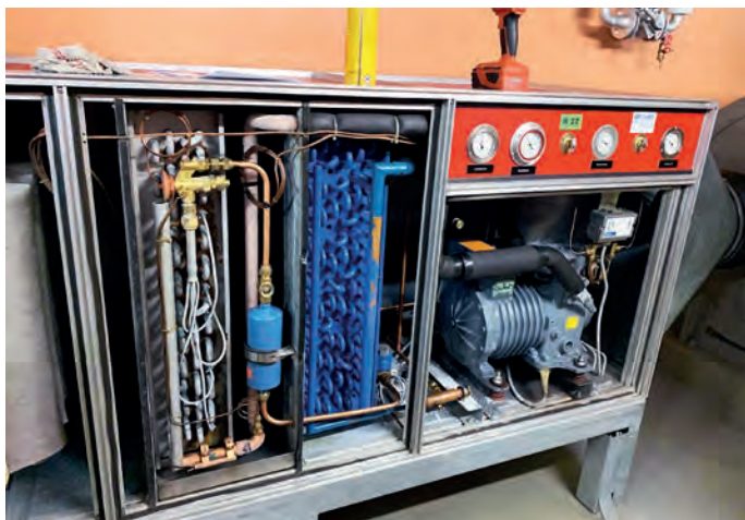
Revision des Hauptentfeuchters im Maschinenraum.
